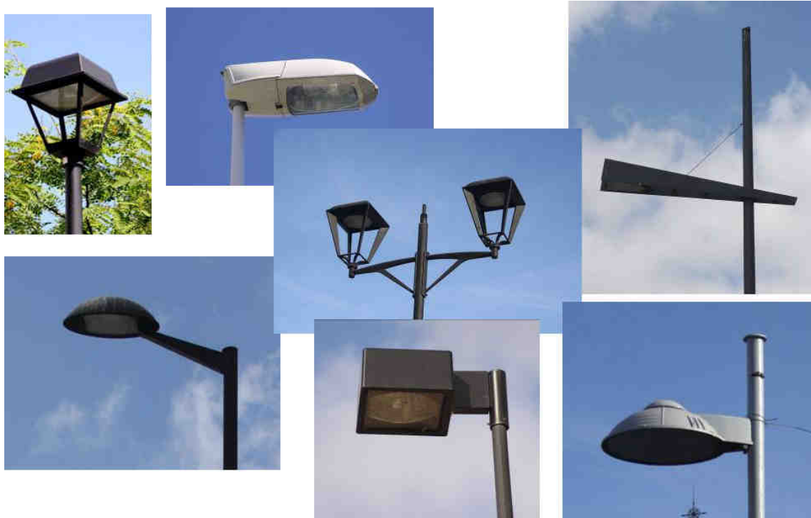
Bild 5: Voll abgeschirmte Leuchten (Teneriffa)
